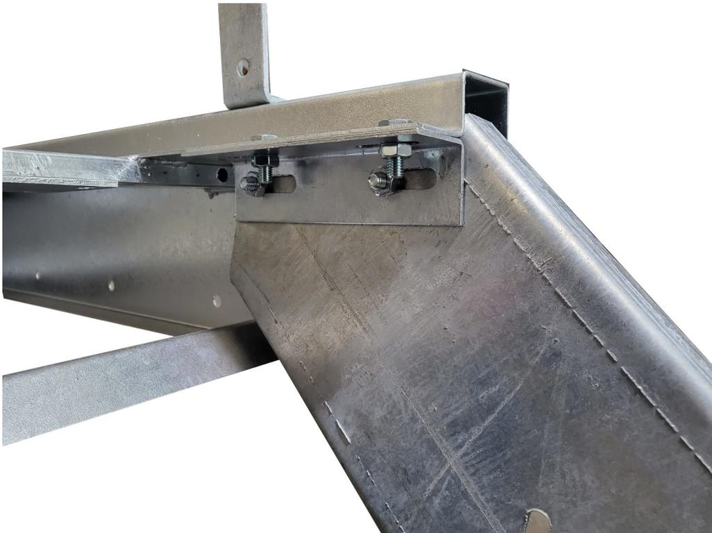
11. Alle restlichen Stufen anbringen und ausrichten.
